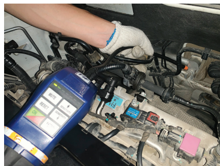
图 5-5-8 检查空调制冷管路是否泄漏
