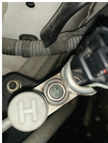
图 5-5-12 通过窥视孔检查制冷剂
